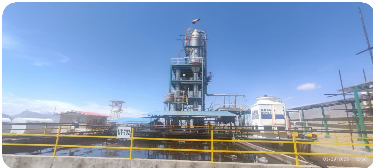
ساخت واحد تصفیه خانه صنعتی (ZLD)
