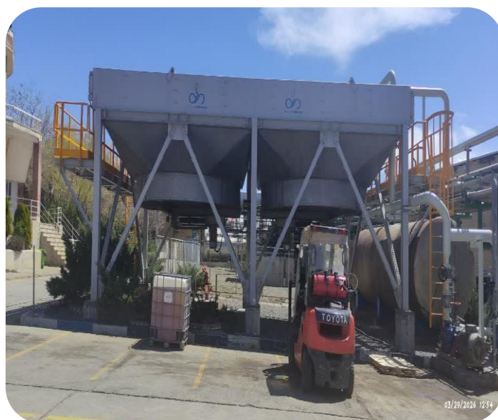
تعویض کولینگ تاورها به ایرکولر جهت کاهش مصرف آب
