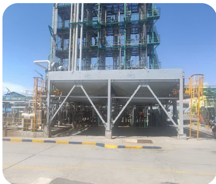
تعویض کولینگ تاورها به ایرکولر جهت کاهش مصرف آب
